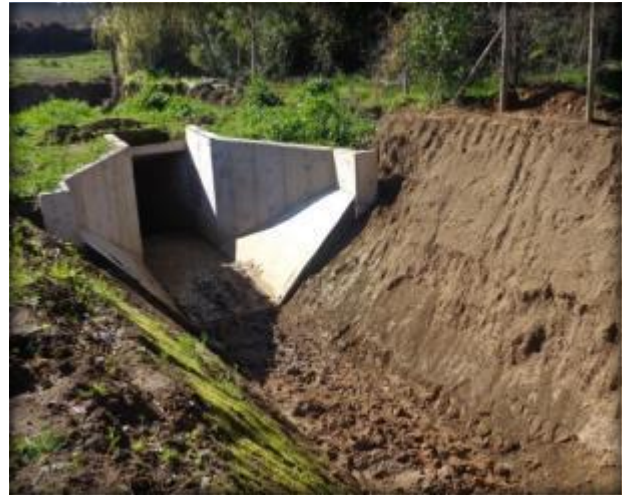
Cámara de salida de Sifón Fortaleza.
