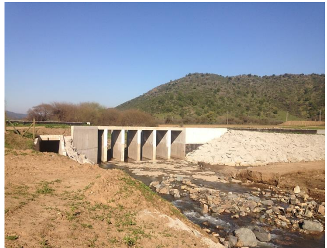
Bocatoma Canal Norte Unificado, barrera frontal.
