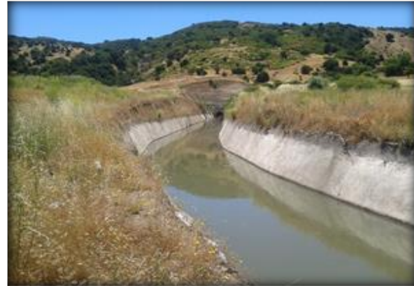
Sector de salida poniente Túnel La Lajuela.
